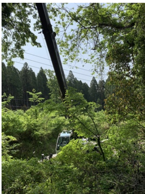
Z069 水中ポンプ引揚工事 1 (2021年5月)
