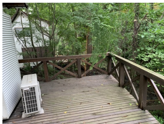
Z123 大雨強風被害 (倒木が室外機を直撃) 2 (2022年7月)
