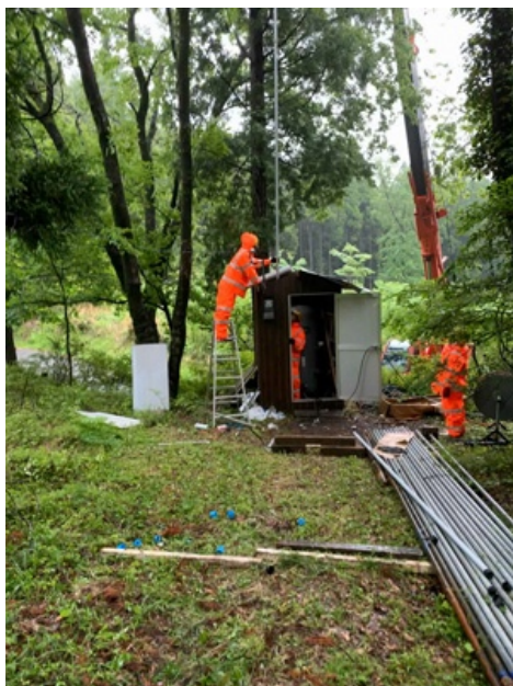
Z088 水中ポンプ設置工事 7 (2021年5月)
