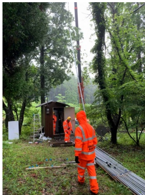
Z086 水中ポンプ設置工事 5 (2021年5月)
