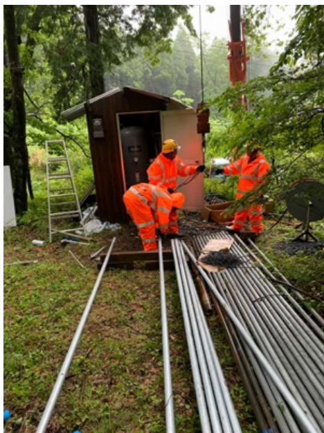
Z084 水中ポンプ設置工事 3 (2021年5月)
