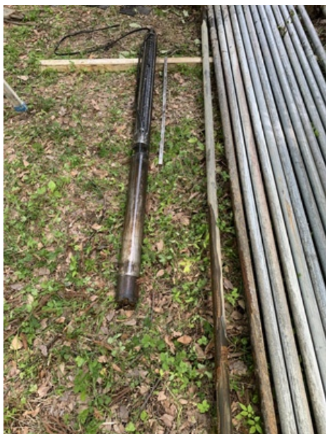
Z072 水中ポンプ引揚工事 4 (2021年5月)
