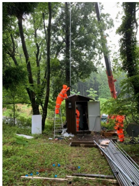
Z087 水中ポンプ設置工事 6 (2021年5月)
