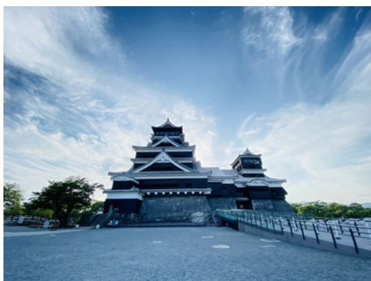
Y040 修復中の熊本城周辺 2（2022年8月）
