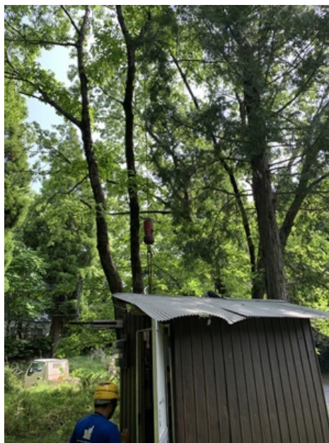
Z070 水中ポンプ引揚工事 2 (2021年5月)
