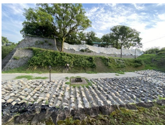
Y041 修復中の熊本城周辺 3（2022年8月）
