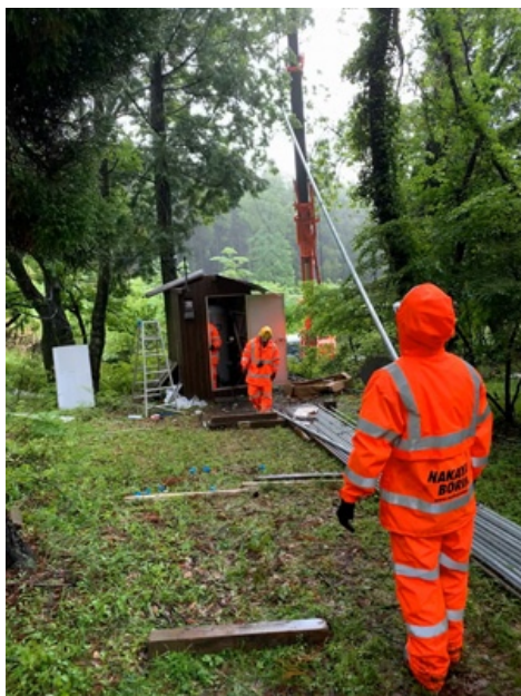
Z085 水中ポンプ設置工事 4 (2021年5月)
