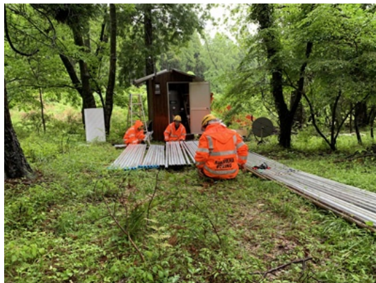
Z082 水中ポンプ設置工事 1 (2021年5月)
