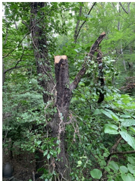
Z122 大雨強風被害 (倒木が室外機を直撃) 1 (2022年7月)
