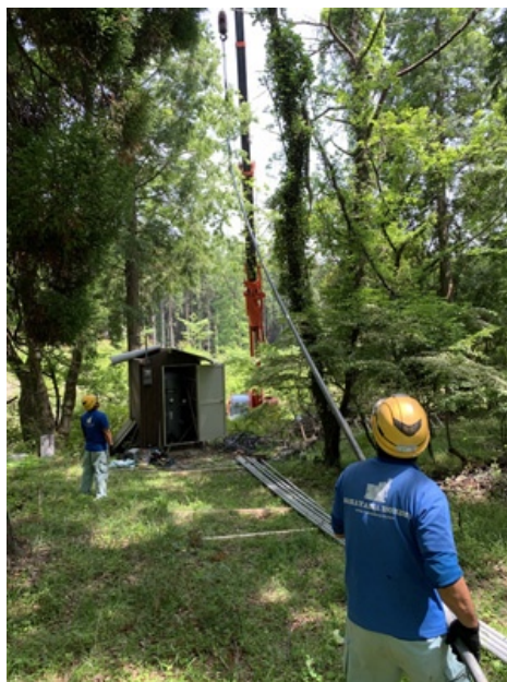
Z071 水中ポンプ引揚工事 3 (2021年5月)
