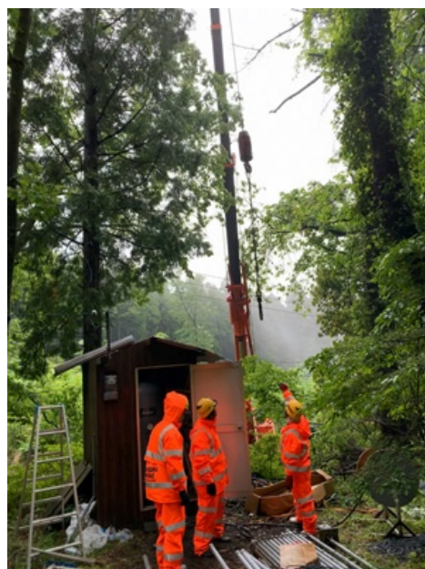
Z083 水中ポンプ設置工事 2 (2021年5月)
