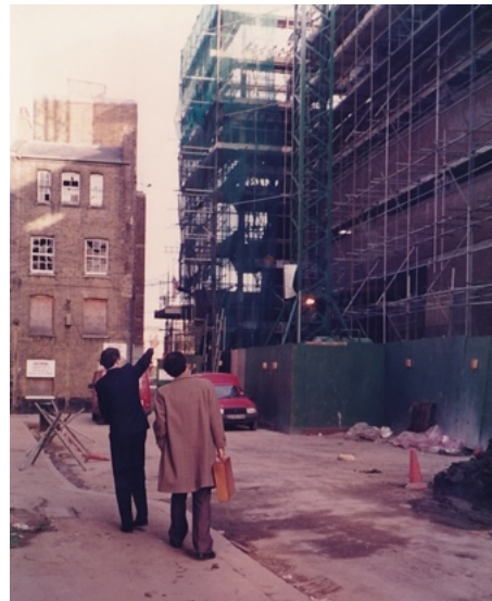
図28 デザイン・ミュージアムの建設現場（1987年）。
