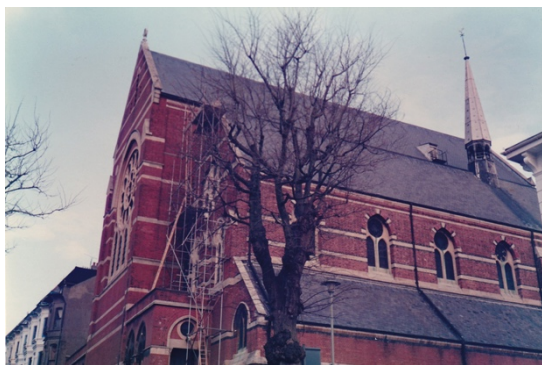
【図05-02】 Brightonのセント・マイケル・アンド・オール・エンジェルズ教会の建物。1987年に撮影。
