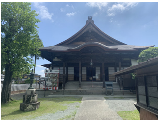
【図 2 0】高群逸枝の守富時代の遊び場であった木原山の不動尊 1 / 全景
