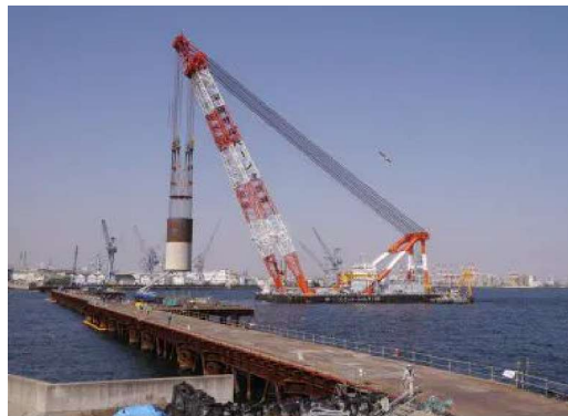
ケーソン曳航状況
