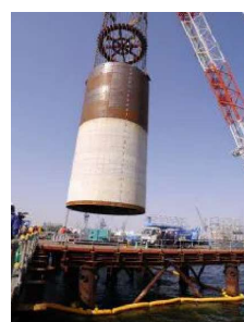
ケーソン吊降ろし状況
