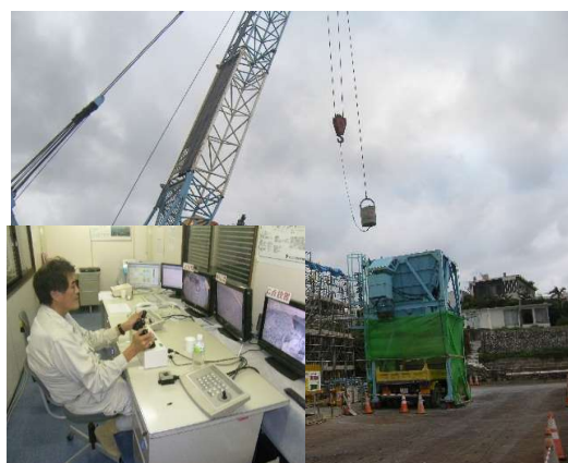
沈下掘削状況（無人掘削：遠隔操作）
