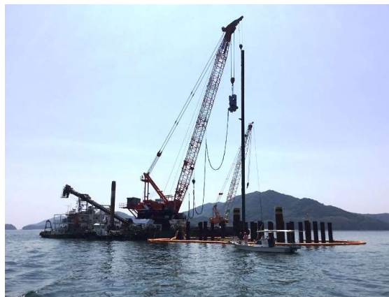
仮設構台・栈橋施工状況
