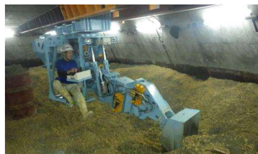
沈下掘削状況（有人掘削）
