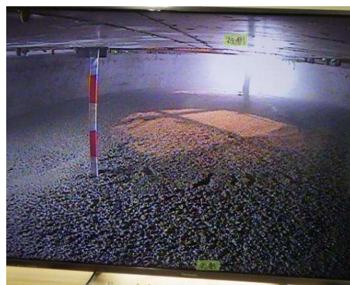
中埋コンクリート打設状況（作業室内）
