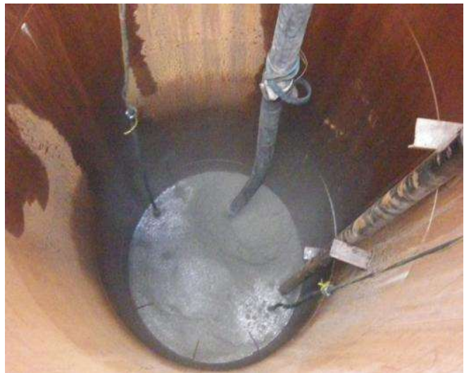
中詰コンクリート打設状況
