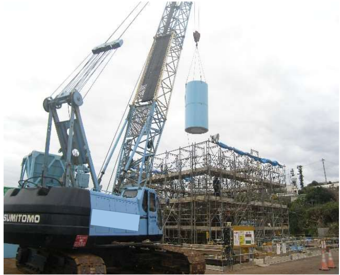
艀装撤去状況
