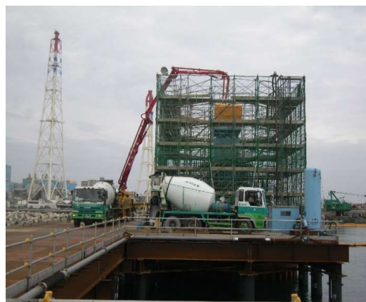
躯体コンクリート打設状況
