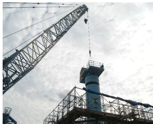
艀装設置状況
