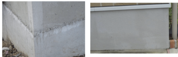
型枠を外したところ
