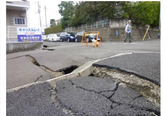
↑ 路面の亀裂。水道・下水管があり。ただし地表地盤には液状化の跡が確認できない。
