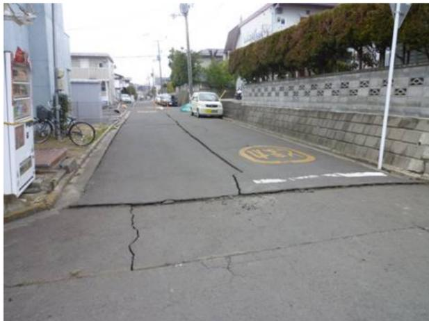
斜面直角方向の道路亀裂。下手(写真左側)に路面亀裂ならびに移動
