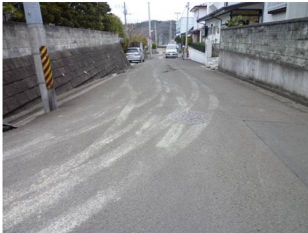
擁壁のブロックが下手にずれ、一部面外に孕む
