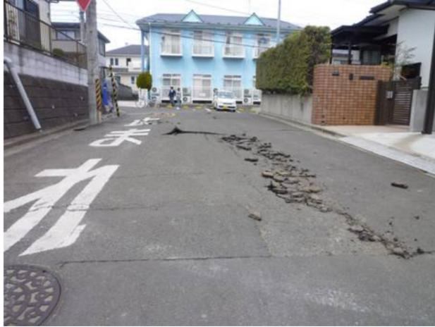
左側より移動し、路面に圧縮亀裂あり
