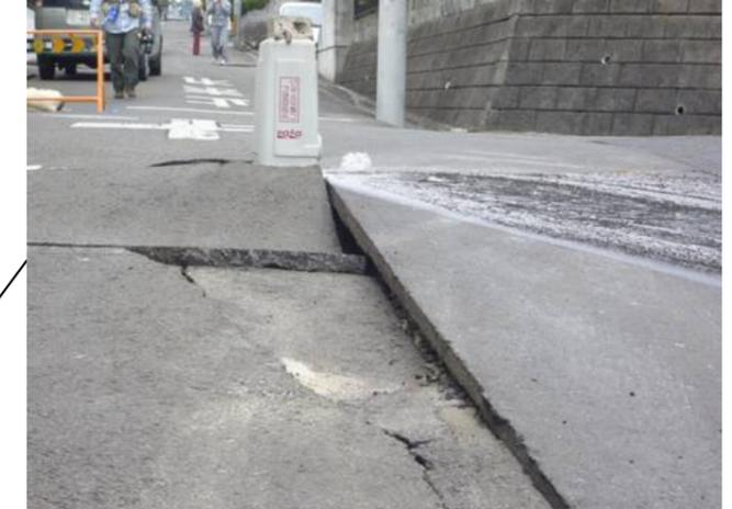
漏水箇所下手で路面の亀裂陥没。左側に下水管あり。
