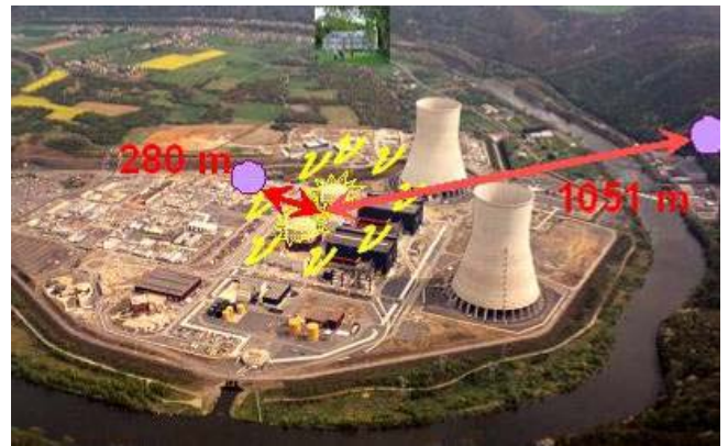
Chooz 原子力発電所と測定装置の位置 発電所は蛇行する川に囲まれている。2つの巨大な円筒状の建造物は、冷却水の蒸気排気筒。原子炉の炉心から 1051 m と 280 m の地下に測定装置を設置する。
